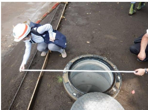
工事監理での寸法確認
